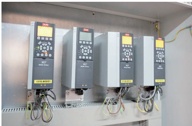
Frekvenčné meniče na reguláciu otáčok kompresorov a čerpadiel v rámci procesu chladenia
